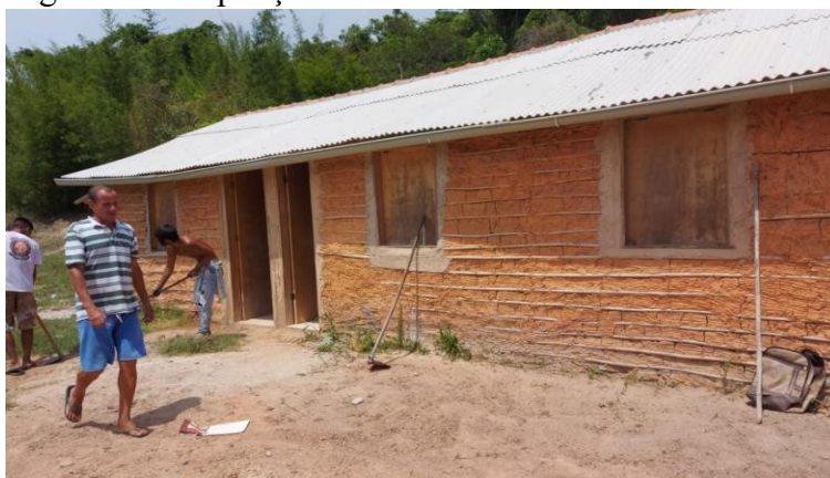
Figura 2 – Ampliação da Escola
