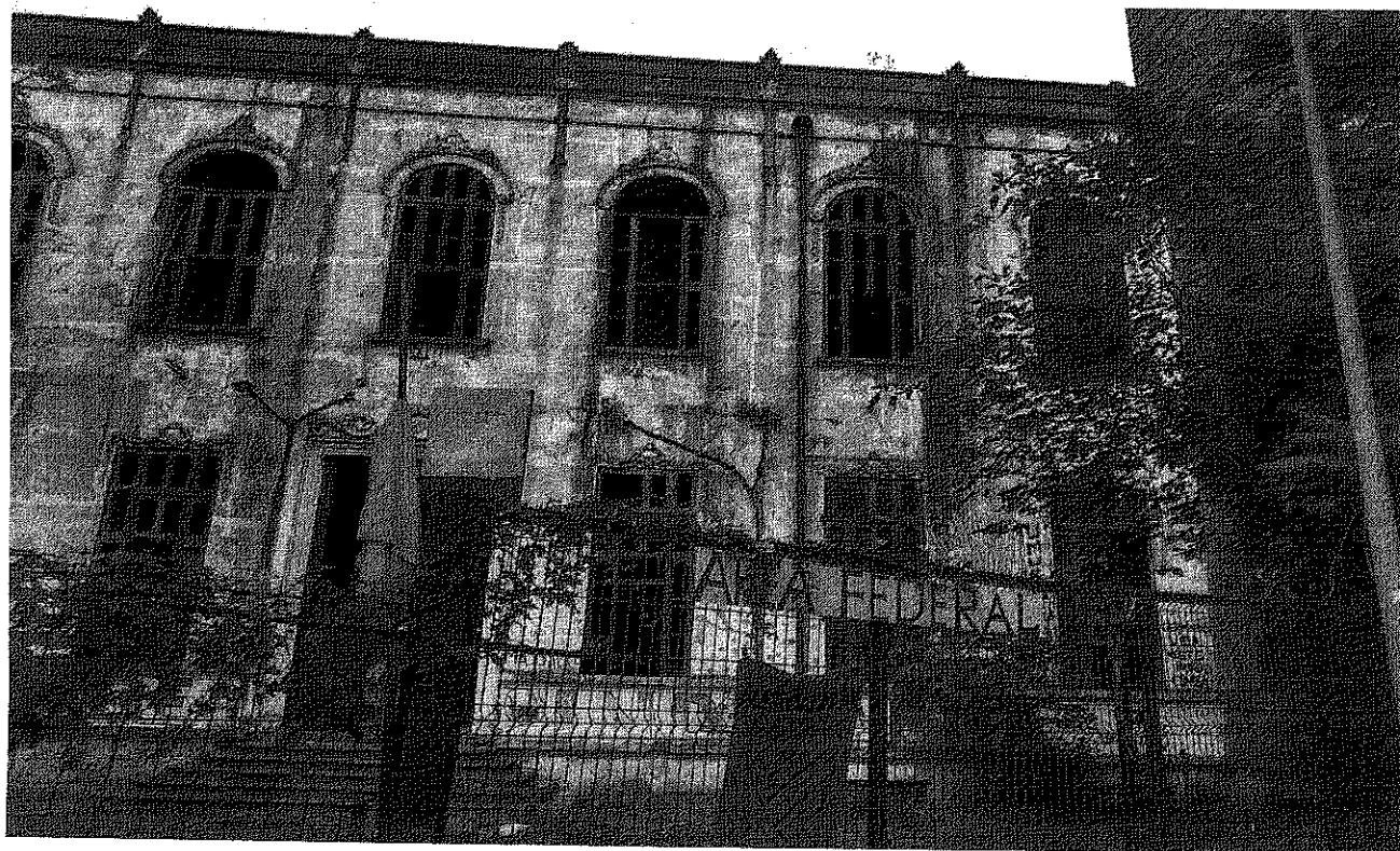
PLANTAS COM RAÍZES DESENVOLVENDO NOS ESPAÇOS VAZIOS DO CONCRETO
