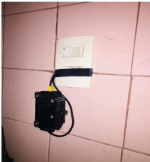
Imagem 27: Improvisos nas instalações elétricas
