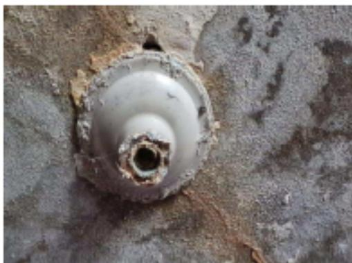
Imagem 29: Infiltrações nos pontos de luz
