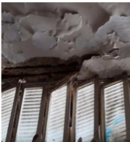
Imagem 8: Desagregação de concreto
